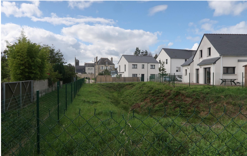
Bassin-tampon en grillagé dans le secteur sud. Il est destiné à être remplacé par une noue.
